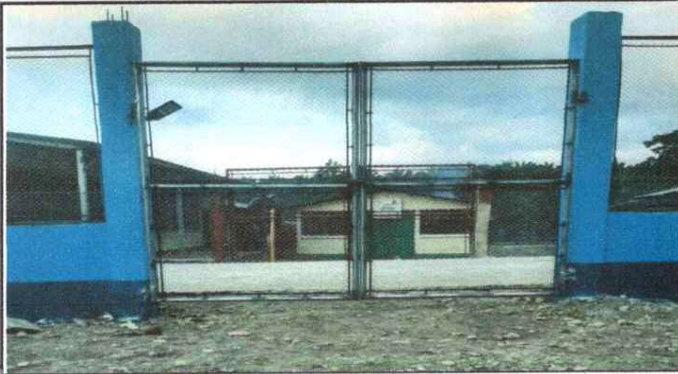
Foto 1: SUSTITUCIÓN DE PORTÓN DE METAL.
