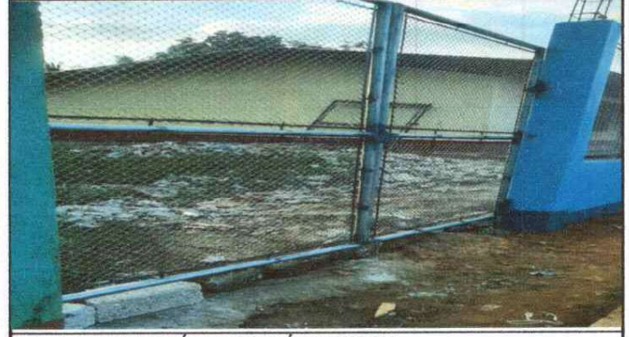
Foto 2: SUSTITUCIÓN DE PORTÓN DE METAL.
