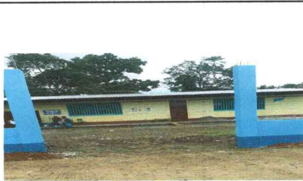
Foto 2: SUSTITUCIÓN DE PORTÓN DE METAL
