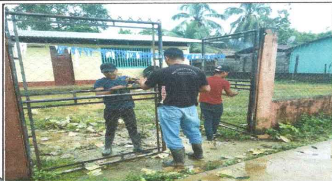
Foto1:SUSTITUCIÓN DE PORTÓN DE METAL
