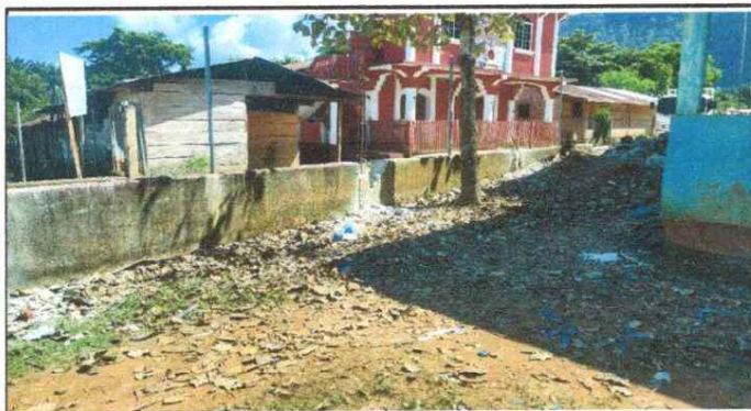
Foto 3: REPARACIÓN DE MURO PERIMETRAL DE BLOCK CON TUBO HG Y MAYA GALVANIZADA.
