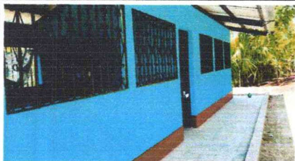
FOTO 7: Pintura en muros exteriores e interiores
