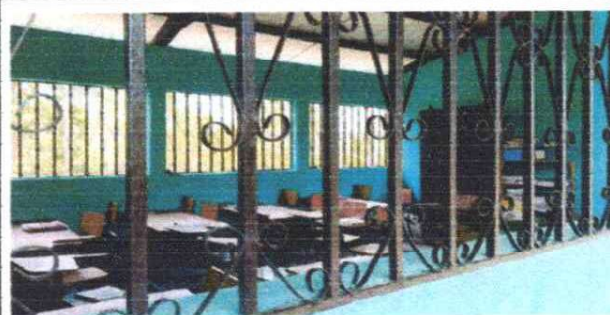
FOTO 4: Mantenimiento de Balcones de metal
