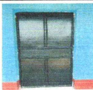
FOTO 3: Lijado, cambio de tubo, cepillado, sujeciones, aplicación de pintura en puerta de metal
