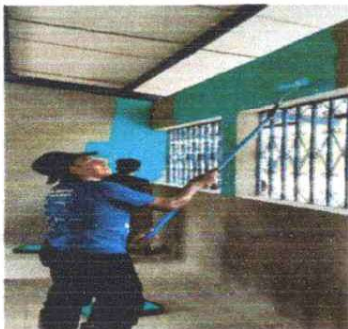
FOTO 7: Pintura en muros exteriores e interiores
