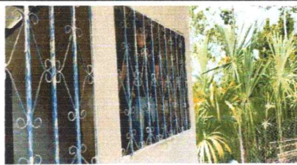
FOTO 4: Mantenimiento de Balcones de metal
