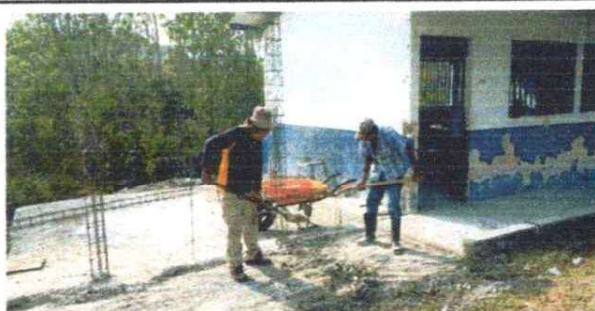
FOTO 5: Sustitución de piso de torta de cemento
