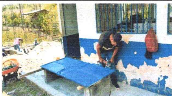
FOTO 3: Lijado, cambio de tubo, cepillado, sujeciones, aplicación de pintura en puerta de metal
