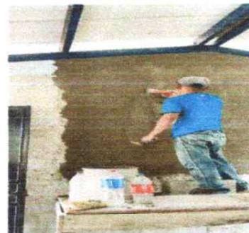
FOTO 8: Repello de paredes
