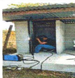
FOTO 6: Sustitución de puertas de madera por metal, en servicios sanitarios.
