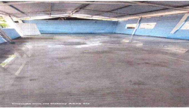
FOTO 3. SUSTITUCION DE PISO EN MALESTADO POR PISO NUEVO
