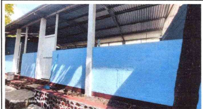
FOTO 6. PINTADA INTERIOR Y EXTERIOR DE LAS AULAS
