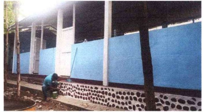
FOTO 4. LEVANTAMIENTO DE TRES HILADAS DE MURO DE AULA Y REPELLO .
