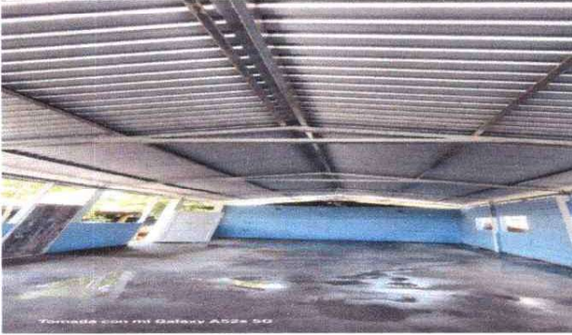
FOTO 1. SUSTITUCION DE LAMINAS EN MAL ESTADO POR LAMINAS TROQUELADAS ALUZIN CALIBRE 26
