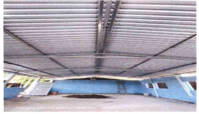
FOTO 2. SUSTITUCION DE ESTRUCTURA DE MADERA POR ESTRUCTURA DE METAL
