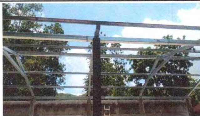
FOTO 4. SUSTITUCION DE ESTRUCTURA DE MADERA POR ESTRUCTURA DE METAL
