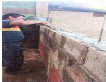
FOTO 11. LEVANTAMIENTO DE TRES HILADAS DE MURO DE AULA
