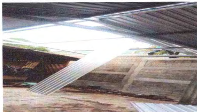
FOTO 1. SUSTITUCION DE LAMINAS POR LAMINAS TROQUELADAS CALIBRE 26
