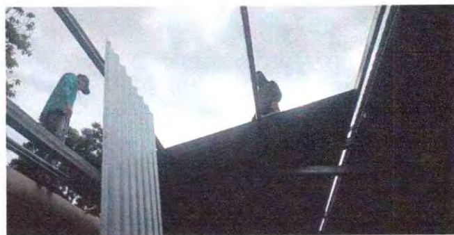
FOTO 2. SUSTITUCION DE LAMINAS POR LAMINAS TROQUELADAS CALIBRE 26
