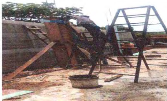
FOTO 9. AVANCE DE SUSTITUCION DE COLUMNA DE MADERA POR COLUMNA DE CONCRETO
