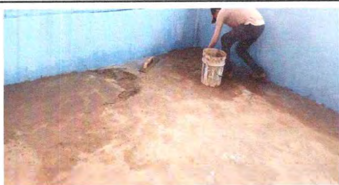
FOTO 7. AVANCE DE SUSTITUCION DE PISO DE CEMENTO
