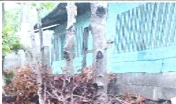
FOTO 14. PINTURA INTERIOR Y EXTERIOR
