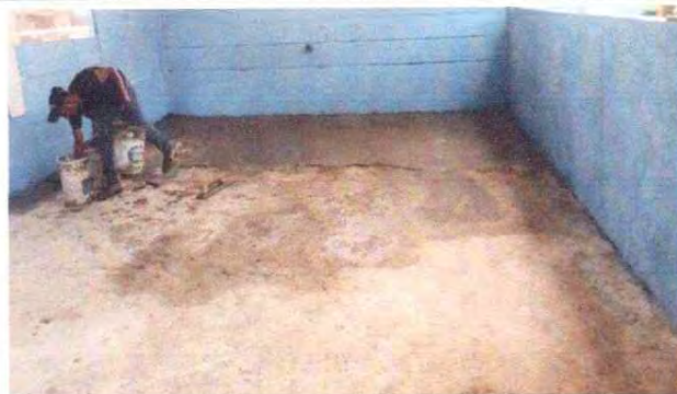
FOTO 6. AVANCE DE SUSTITUCION DE PISO DE CONCRETO
