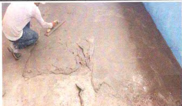
FOTO 5. AVANCE DE SUSTITUCION DE PISO DE CEMENTO
