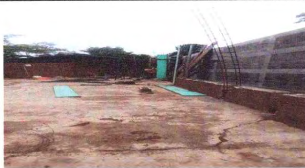
FOTO 8. AVANCE DE SUSTITUCION DE COLUMNA DE MADERA POR COLUMNA DE CONCRETO
