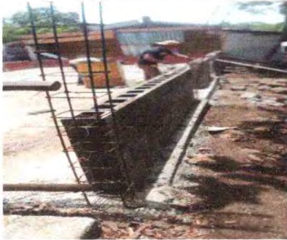
FOTO 10. LEVANTAMIENTO DE TRES HILADAS DE MURO DE AULA
