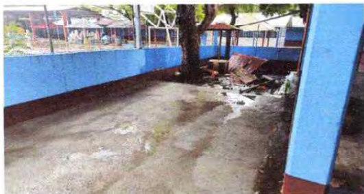
FOTO 3: REPARACION DE PISO TORTA
