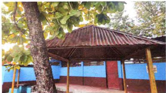
FOTO 13: PINTURA EN MUROS INTERIOR Y EXTERIOR
