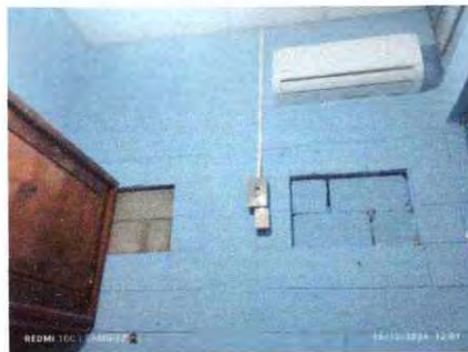
Foto 8: PINTURA EN MUROS INTERIOR Y EXTERIOR
