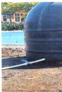
FOTO 19: SUSTITUCION DE DEPOSITO DE AGUA 1700 LITROS
