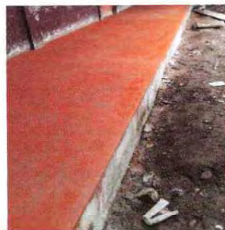
FOTO 2: REPARACION DE PISO TORTA
