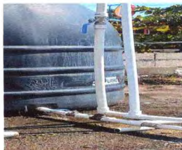
FOTO 20: SUSTITUCION DE DEPOSITO DE AGUA 1700 LITROS
