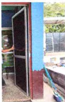
FOTO 15: SUSTITUCION DE PUERTAS DE METAL
