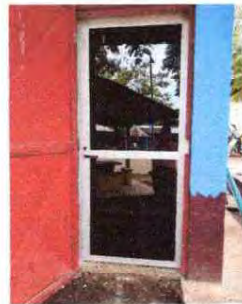
FOTO 14: SUSTITUCION DE PUERTAS DE METAL
