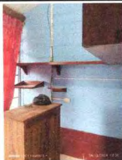
Foto 11: PINTURA EN MUROS INTERIOR Y EXTERIOR
