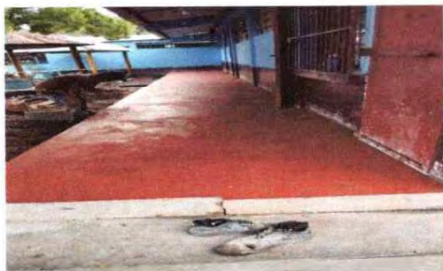
FOTO 1: REPARACION DE PISO TORTA
