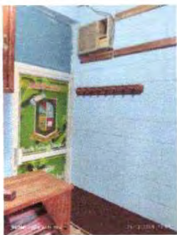
Foto 7: PINTURA EN MUROS INTERIOR Y EXTERIOR
