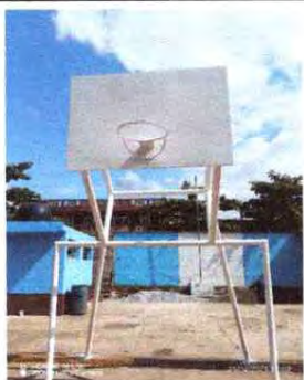
FOTO 21: MANTENIMIENTO DE CANASTA
