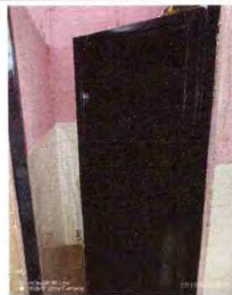
FOTO 16: MANTENIMIENTO DE PUERTAS
