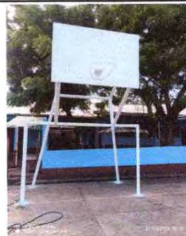
FOTO 22: MANTENIMIENTO DE CANASTA
