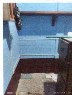
Foto 10: PINTURA EN MUROS INTERIOR Y EXTERIOR
