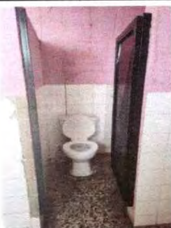
FOTO 5: SUSTITUCION DE SANITARIOS
