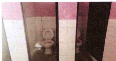
FOTO 4: SUSTITUCION DE SANITARIOS
