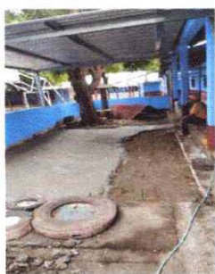
FOTO 3: REPARACION DE PISO TORTA
