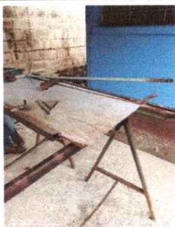
FOTO 11: MANTENIMIENTO DE PUERTAS DE METAL
