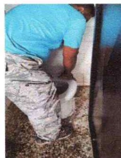
FOTO 4: SUSTITUCION DE SANITARIOS
