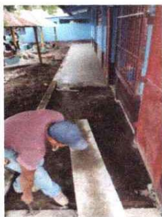
FOTO 1: REPARACION DE PISO TORTA
