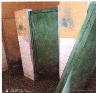
FOTO 13: MANTENIMIENTO DE PUERTAS DE METAL
