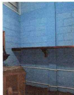
FOTO 8: PINTURA EN MUROS INTERIOR Y EXTERIOR
