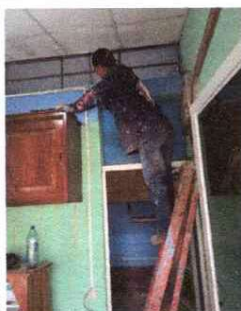
FOTO 5: PINTURA EN MUROS INTERIOR Y EXTERIOR
