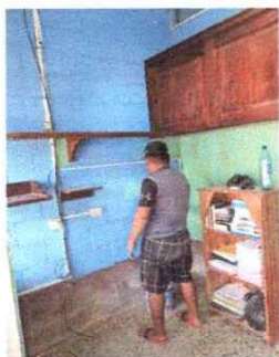
FOTO 7: PINTURA EN MUROS INTERIOR Y EXTERIOR
