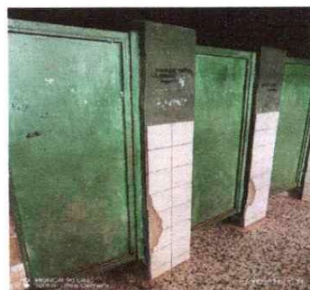
FOTO 12: MANTENIMIENTO DE PUERTAS DE METAL
