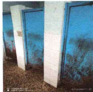
FOTO 14: MANTENIMIENTO DE PUERTAS DE METAL
