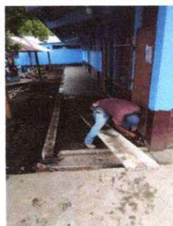
FOTO 2: REPARACION DE PISO TORTA
