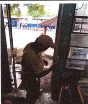
FOTO 9: MANTENIMIENTO DE PUERTAS DE METAL
