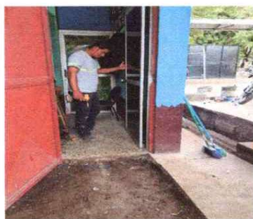
FOTO 10: SUSTITUCION DE PUERTAS DE METAL
