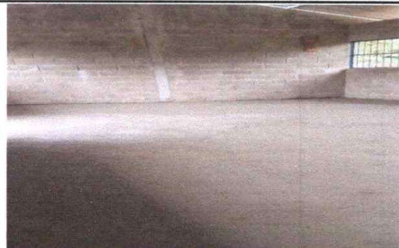
FOTO 4: SUSTITUCIÓN DE PISO DE TORTA.
