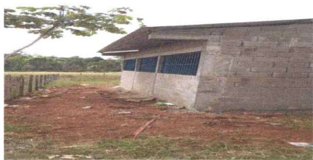
FOTO 5: INSTALACIÓN DE BALCONES DE METAL.
