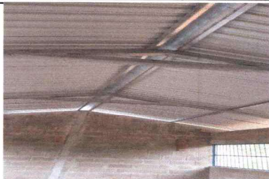
FOTO 2: INSTALACIÓN DE ESTRUCTURA METALICA.
