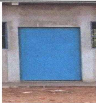
FOTO 6: INSTALACIÓN DE PUERTAS.
