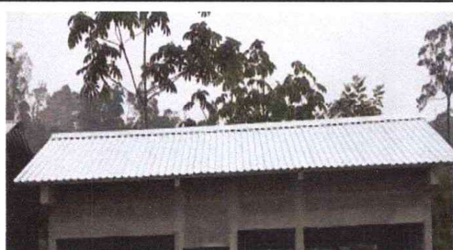
FOTO 3: INSTALACIÓN DE LAMINA TROQUELADA
