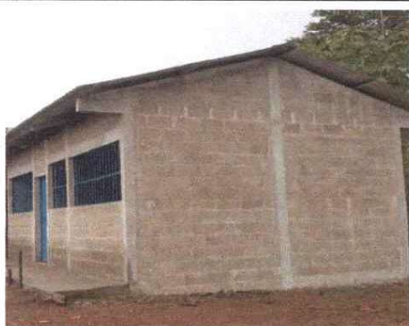
FOTO 1: LEVANTAMIENTO DE MURO PERIMETRAL.
