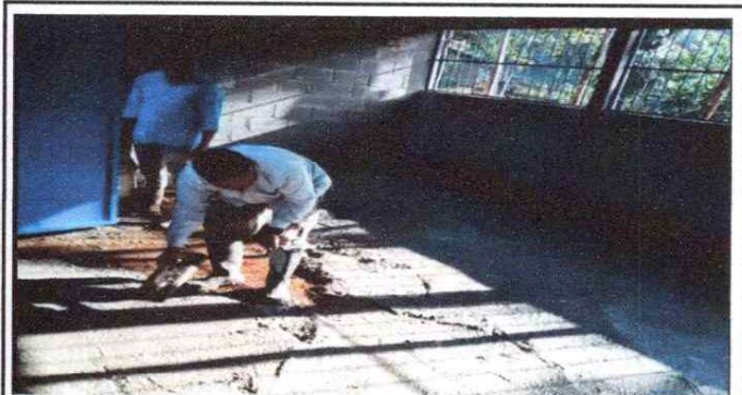
FOTO 4: SUSTITUCIÓN DE PISO DE TORTA DE CONCRETO.
