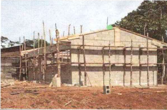
FOTO 1:LEVANTAMIENTO DE MURO PERIMETRAL.
