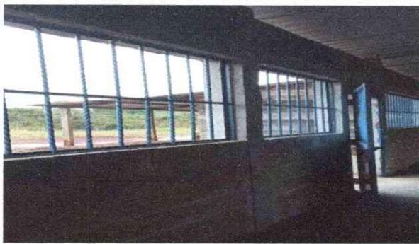
FOTO 5:INSTALACIÓN DE BALCONES DE METAL.
