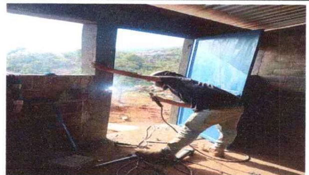
FOTO 6: INSTALACIÓN DE PUERTAS.
