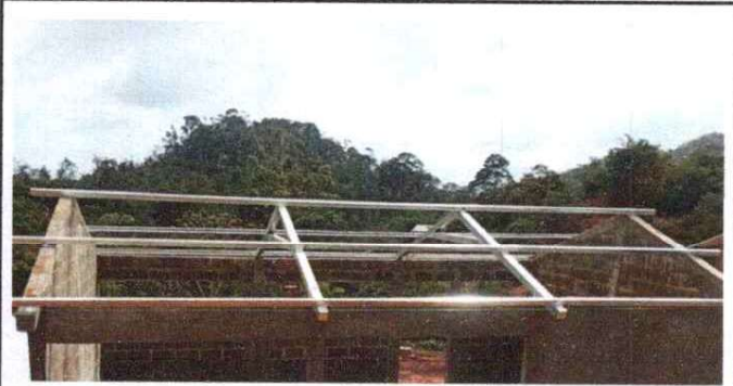
FOTO 2:INSTALACIÓN DE ESTRUCTURA METALICA.
