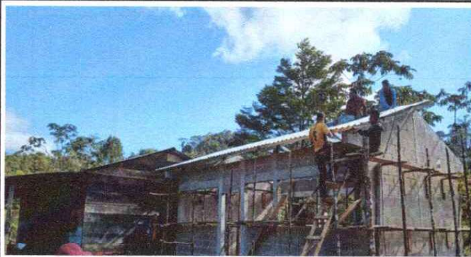
FOTO 3: INSTALACIÓN DE LAMINA TROQUELADA.
