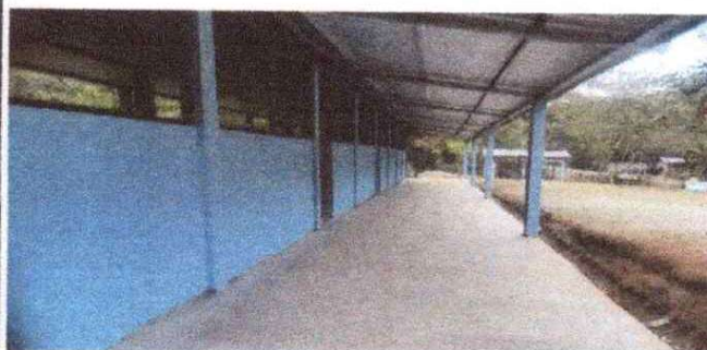
FOTO 6: Reparación de loza de concreto de patio
