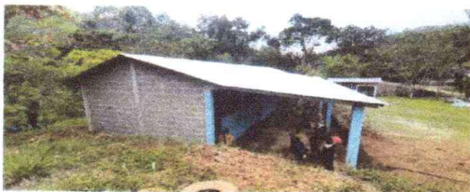
FOTO 1: Sustrucción de lámina, por lámina troquelada aluzinc calibre 26
