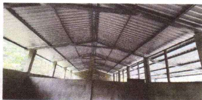
FOTO 4: Sustrucción de estructura de soporte de madera, por metal
