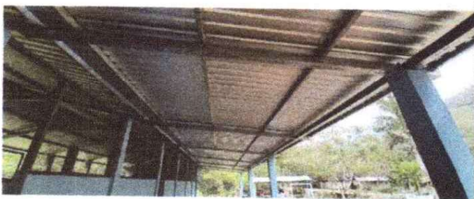
FOTO 3: Sustrucción de estructura de soporte de madera, por metal
