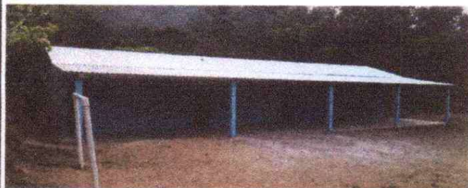
FOTO 2: Sustrucción de lámina, por lámina troquelada aluzinc calibre 26
