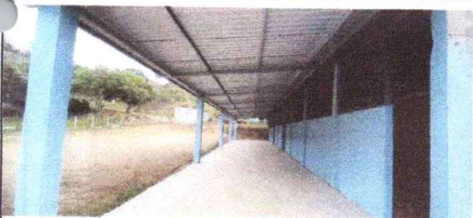
FOTO 5: Reparación de loza de concreto de patio
