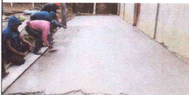
FOTO 6: Reparación de loza de concreto de patio
