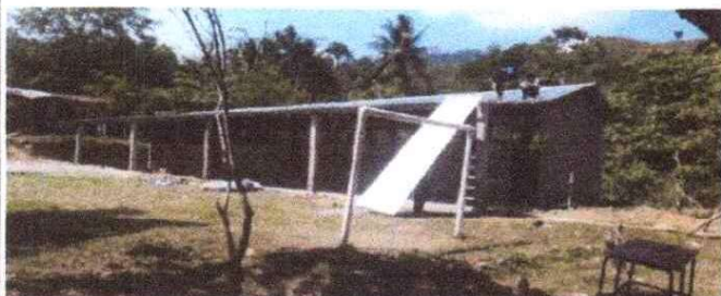
FOTO 1: Sustrucción de lámina, por lamina troquelada aluzinc calibre 26
