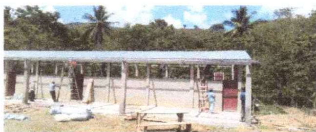
FOTO 2: Sustrucción de lámina, por lámina troquelada aluzinc calibre 26
