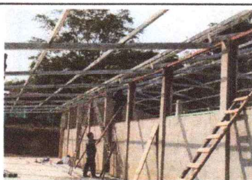
FOTO 4: Sustrucción de estructura de soporte de madera, por metal
