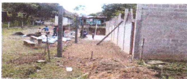
FOTO 5: Reparación de loza de concreto de patio
