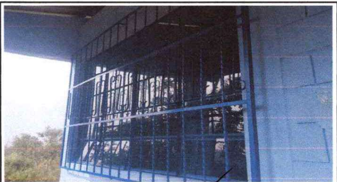
FOTO 4. SUSTITUCION DE BALCONES DE METAL
