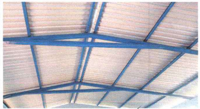
FOTO 2. SUSTITUCIÓN DE ESTRUCTURA DE SOPORTE DE METAL POR METAL
