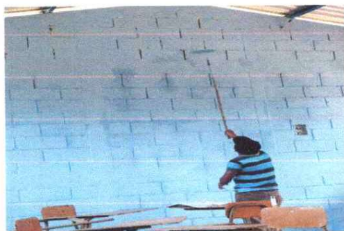
Foto 5: PINTADA EN MURO EXTERIORES E INTERIORES.
