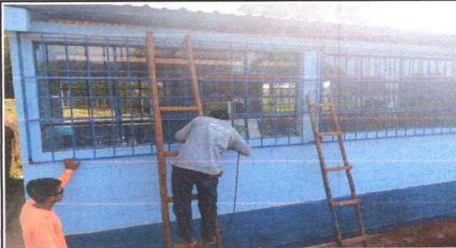
FOTO 4. SUSTITUCION DE BALCONES DE METAL
