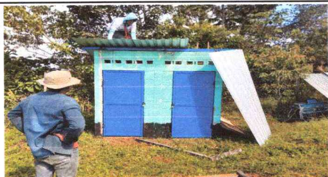
FOTO3: SUSTITUCIÓN DE PUERTAS EN SERVICIOS SANITARIO
