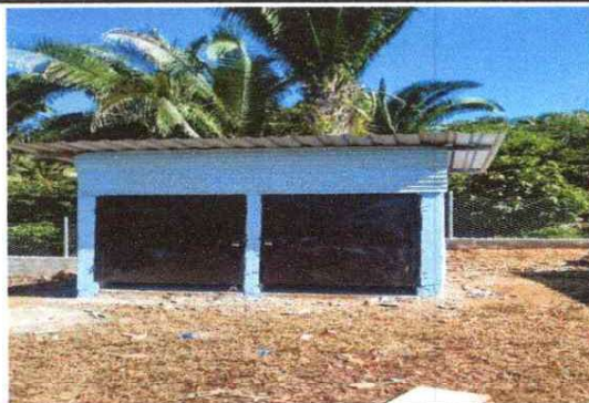
Foto 4: SUSTITUCION DE PUERTA EN SERVICIOS SANITARIOS
