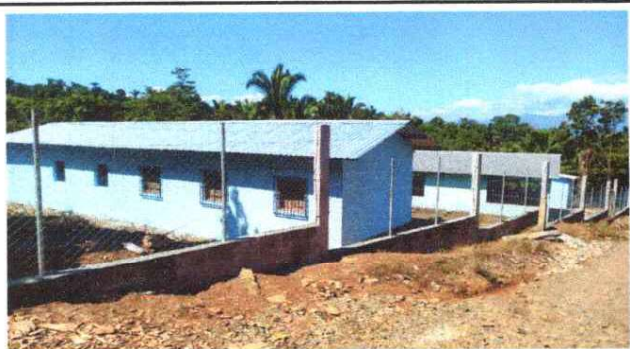
Foto 5: REPARACION DE MURO PERIMETRAL DE BLOCK CON TUBO HG Y MALLA GALVANIZADA, SOLERA, INTERMEDIA Y COLUMNAS
