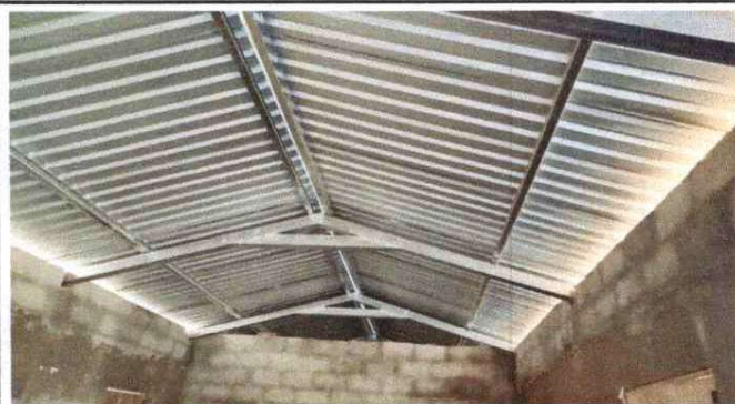
Foto 2: SUSTITUCION ESTRUCTURA DE SOPORTE DE MADERA POR METAL
