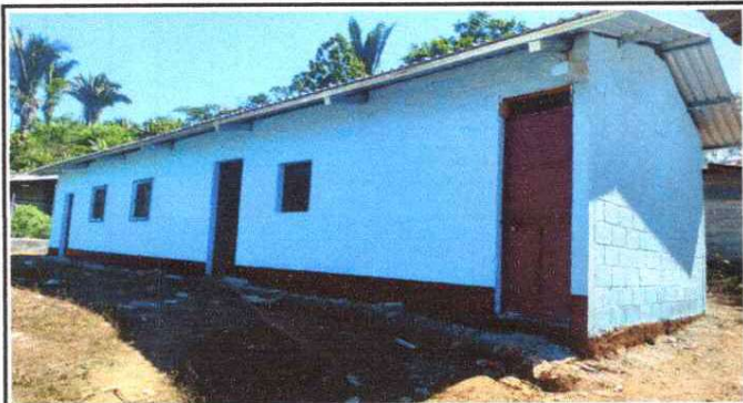
Foto1: SUSTITUCION DE LAMINA POR LAMINA TROQUELADA CALIBRA 26
