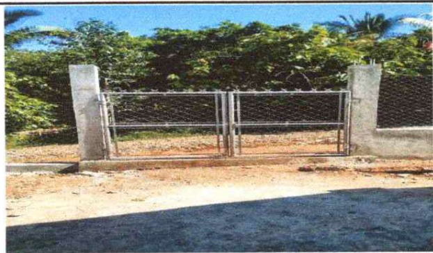
Foto 3: SUSTITUCIO DE PORTON DE METAL
