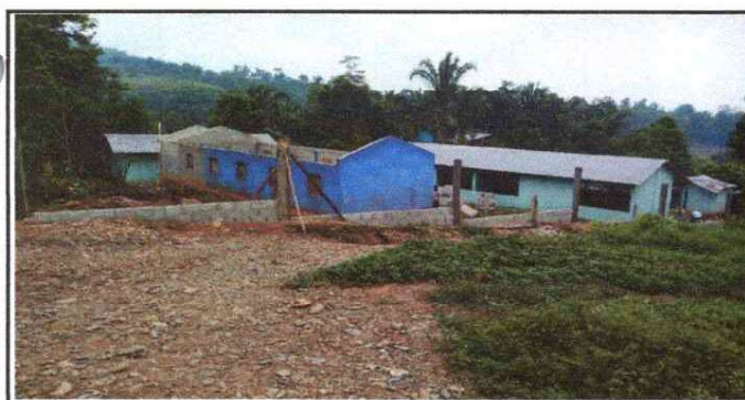
Foto 5: SUSTITUCION DE MURO PERIMETRAL DE BLOCK, TUBO HG Y MALLA GALVANIZADA. SOLERAS, INTERMEDIAS Y COLUMNAS
