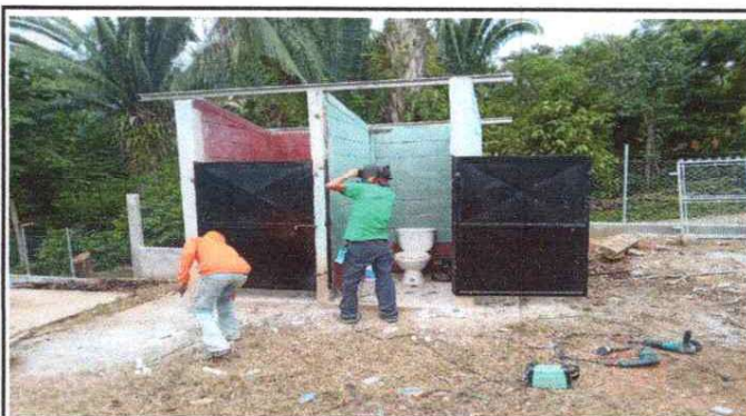
Foto 4: SUSTITUCION DE PUERTAS DE SERVICIO SANITARIO
