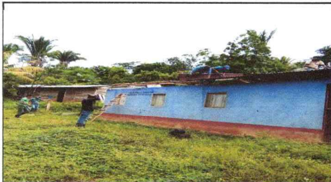
Foto1: AVANCE DE SUSTITUCION DE CUBIERTA DE LAMINA
