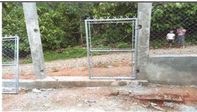
Foto 3: SUSTITUCION DE PORTON DE METAL
