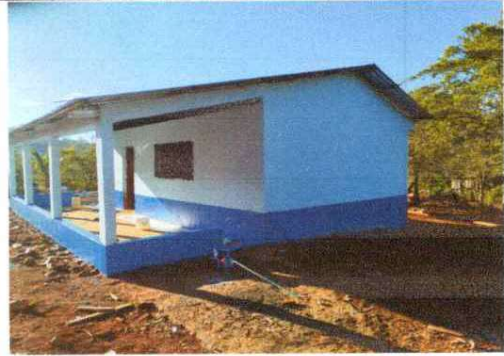
Foto 2: Realización de repello y cernido de paredes.
