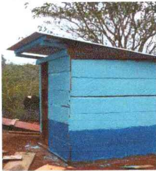
Foto 3: Realización de techo y torta de piso de concreto de sanitario
