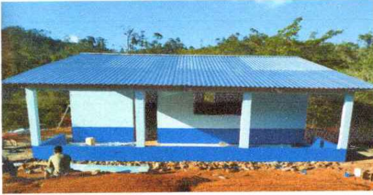
Foto 1: Finalización de estructura y cubierta de lamina
