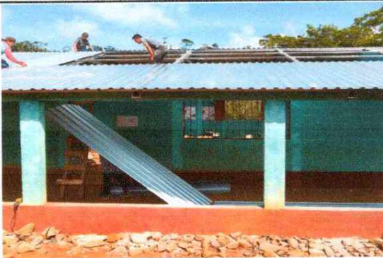
Foto 3: Sustrucion de laminas por laminas troqueladas
