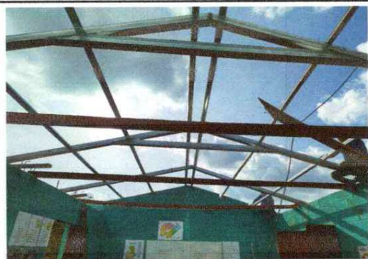
Foto 2: Colocacion de estructura metalica
