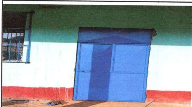
Foto 3: MANTENIMIENTO Y REPARACIÓN DE UNA PUERTA PRINCIPAL.
