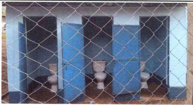
Foto 9: SUSTITUCIÓN DE INODOROS.
