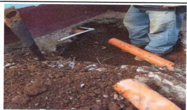
Foto 10: SUSTITUCIÓN DE TUBERIA LINEA PRINCIPAL.
