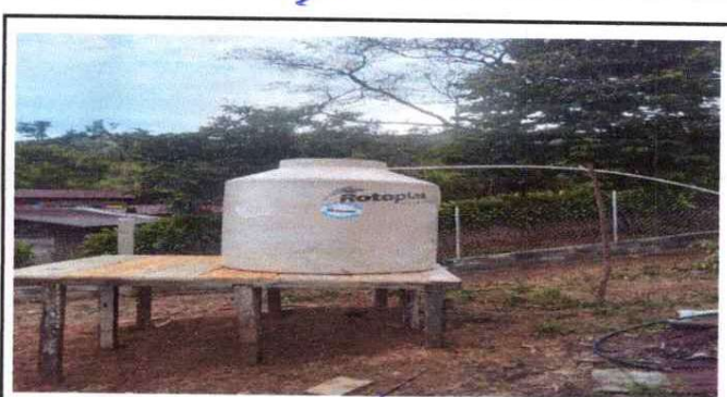
Foto 6: INSTALACIÓN DE ROTOPLAS.
