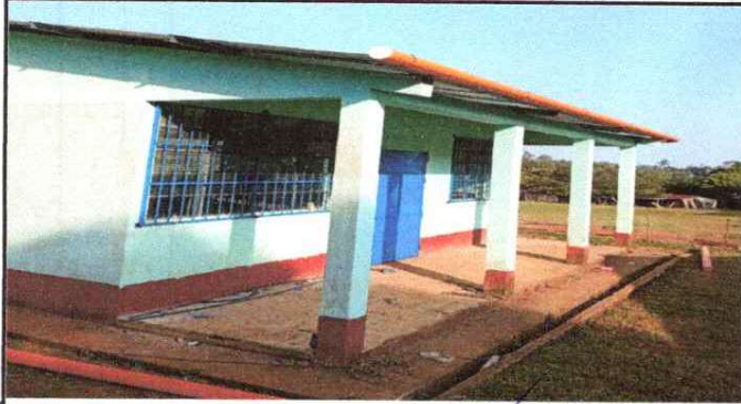
Foto7: SUSTITUCIÓN DE CANAL DE PVC
