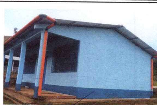
Foto 8: PINTURA EN MUROS EXTERIORES.
