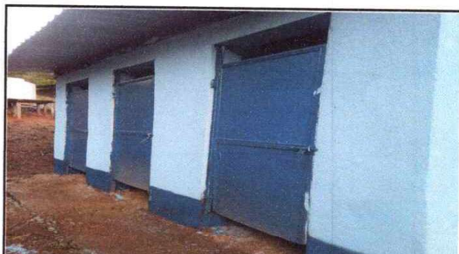
Foto4: MANTENIMIENTO Y REPARACIÓN DE PUERTAS DE SANITARIOS.
