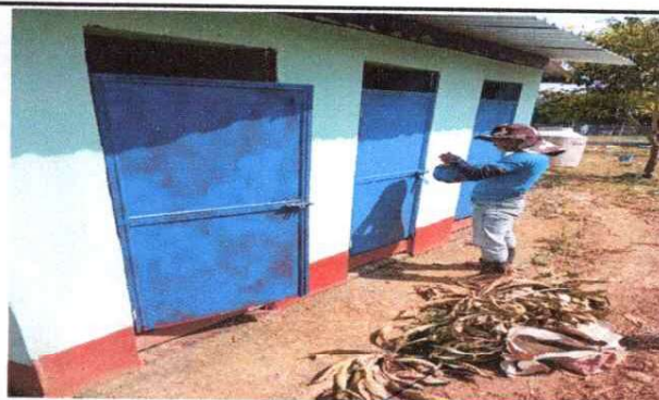
Foto 4: MANTENIMIENTO Y REPARACIÓN DE PUERTAS DE SANITARIOS.
