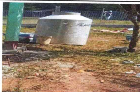
FOTO. INSTALACIÓN DE ROTOPLAS.
