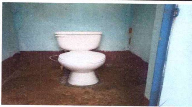
Foto 9: SUSTITUCIÓN DE INODORO
