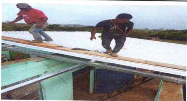
Foto1: SUSTITUCIÓN DE LÁMINA, POR LÁMINA TROQUELADA ALÚZINC CALIBRE 26
