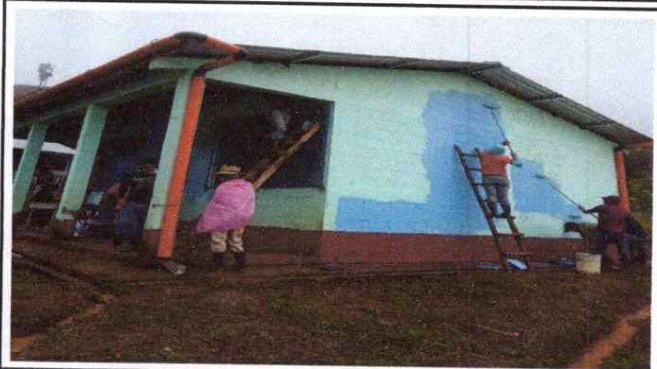
Foto 8: PINTURA EN MUROS EXTERIORES
