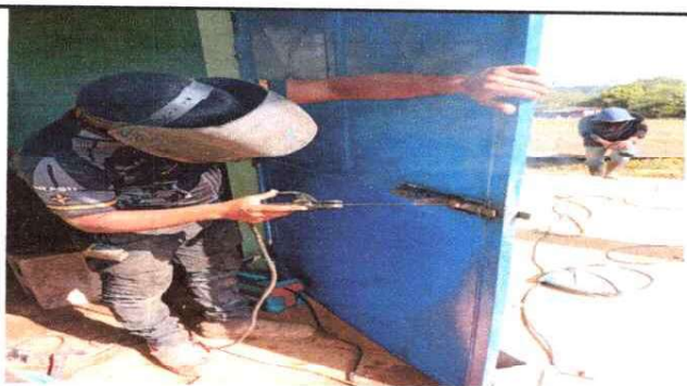
Foto 3 SUSTITUCIÓN DE PUERTAS.
