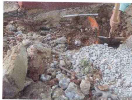
Foto 10: SUSTITUCIÓN DE TUBERIA LINEA PRINCIPAL
