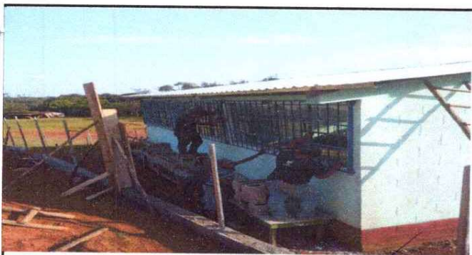
FOTO 5. SUSTITUCIÓN DE BALCONES DE METAL
