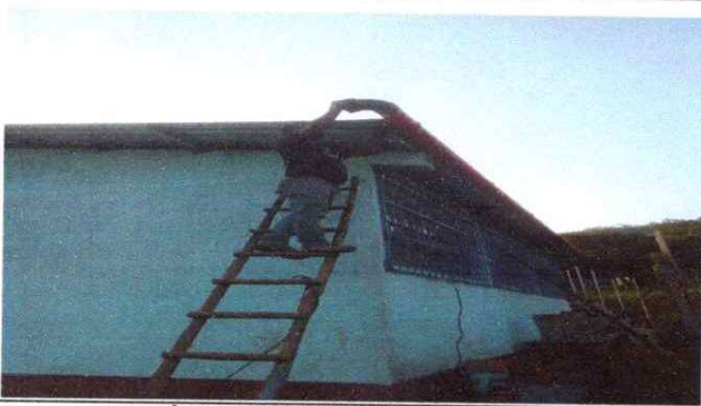
Foto 7: SUSTITUCIÓN DE CANAL DE PVC
