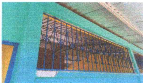
FOTO 5: SUSTITUCIÓN DE VENTANAS DE VIDIO POR BALCONES
