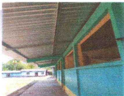
FOTO 1: SUSTITUCION DE LÁMINA, POR LÁMINA TROQUELADA ALUZINC
