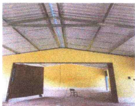
FOTO 3: SUSTITUCIÓN DE ESTRUCTURA DE METAL POR METAL
