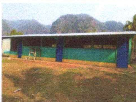
FOTO 4: SUSTITUCION DE PUERTAS DE MADERA POR METAL
