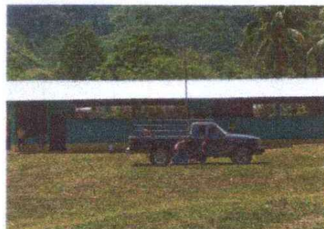
FOTO 2: SUSTITUCION DE LÁMINA POR LÁMINA TROQUELADA ALUZINC
