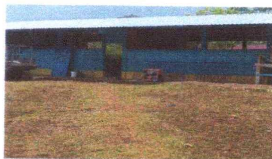
FOTO 4: SUSTITUCION DE PUERTAS DE MADERA POR METAL
