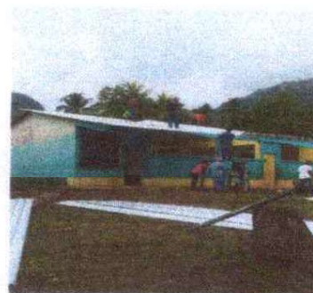
FOTO 2: SUSTITUCION DE LÁMINA POR LÁMINA TROQUELADA ALUZINC
