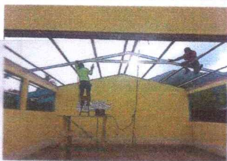
FOTO 3: SUSTITUCIÓN DE ESTRUCTURA DE METAL POR METAL
