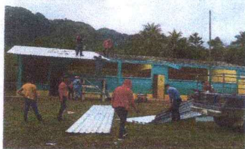
FOTO 1: SUSTITUCION DE LÁMINA, POR LÁMINA TROQUELADA ALUZINC
