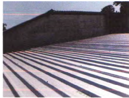
FOTO 2: SUSTITUCION DE LAMINA POR LAMINA TROQUELADA
