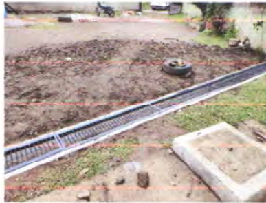
FOTO 7: INSTALACION DE PARRILLA DE METAL PARA CUNETAS
