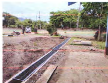
FOTO 6: INSTALACION DE PARRILLA DE METAL PARA CUNETA
