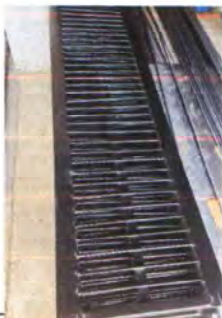
FOTO 5: INSTALACION DE PARRILLA DE METAL PARA CUNETA
