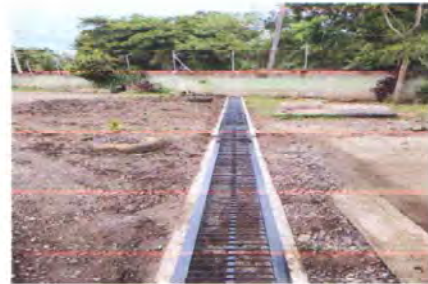
Foto 8: INSTALACION DE PARRILLA DE METAL PARA CUNETAS
