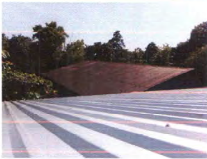
FOTO 1: SUSTITUCION DE LAMINA POR LAMINA TROQUELADA
