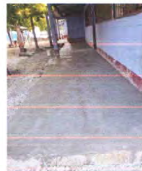
Foto 10: REPARACION DE PISO TORTA DE CONCRETO
