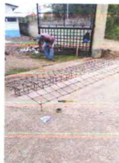
FOTO 8: ELABORACION DE TUMULO DE CONCRETO
