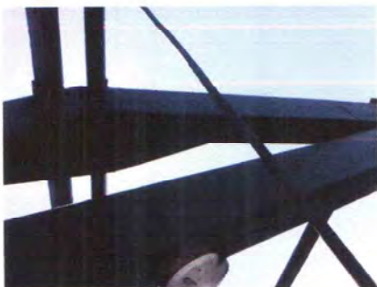
FOTO 3: SUSTITUCION DE ESTRUCTURA DE METAL
