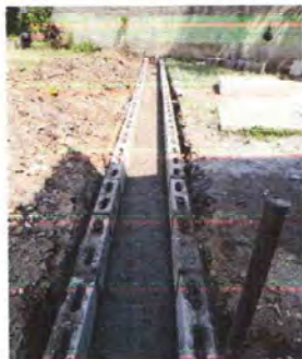
Foto 5: ELABORACION DE CUNETA
