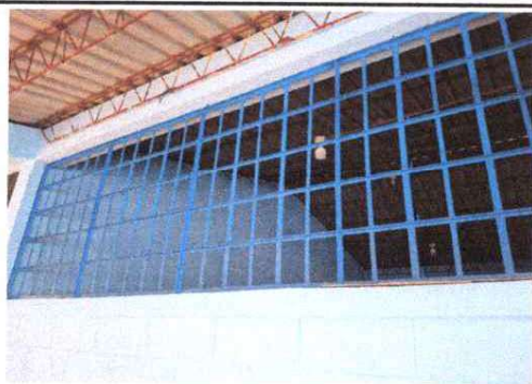
Foto 3: MANTENIMIENTO A BALCONES DE METAL
