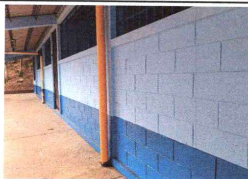
Foto 4: PINTURA EN MUROS EXTERIORES E INTERIORES
