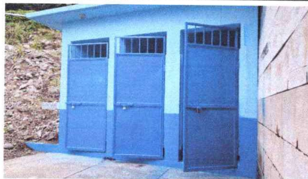
Foto 2: SUSTITUCION DE PUERTAS DE SERVICIOS SANITARIOS
