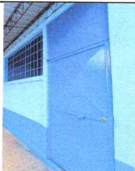
Foto1: MANTENIMIENTO A ESTRUCTURA (LIJADO, CAMBIO DE TUBO, CEPILLADO, SUJECIONES APLICACIÓN DE PINTURA)
