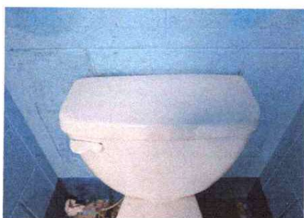
Foto 5: SUSTITUCION DE ACCESORIOS DE INODORO
