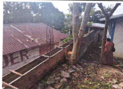
REPARACION DE MURO PERIMETRAL.
