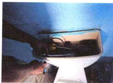
Foto 5: SUSTITUCION DE ACCESORIOS DE INODORO
