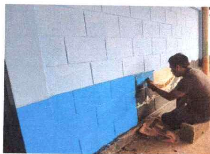
Foto 5: PINTURA EN MUROS EXTERIORES E INTERIORES
