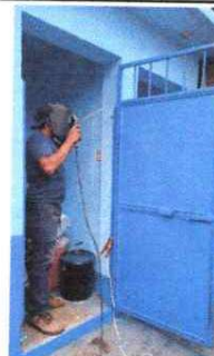
Foto 2: SUSTITUCION DE PUERTAS DE SERVICIOS SANITARIOS
