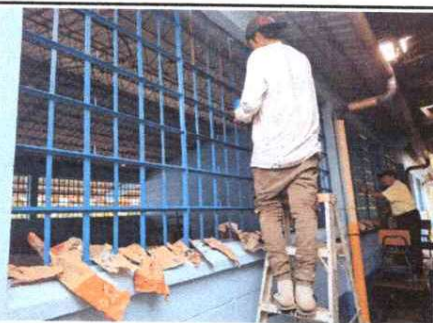
Foto 2: MANTENIMIENTO A BALCONES DE METAL
