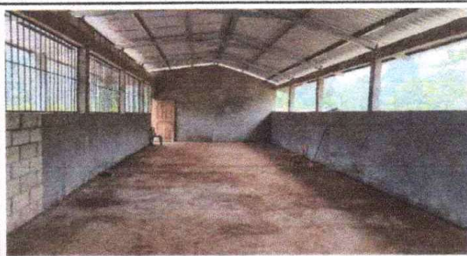
FOTO 2: SUSTITUCIÓN DE ESTRUCTURA DE MADERA POR METAL.
