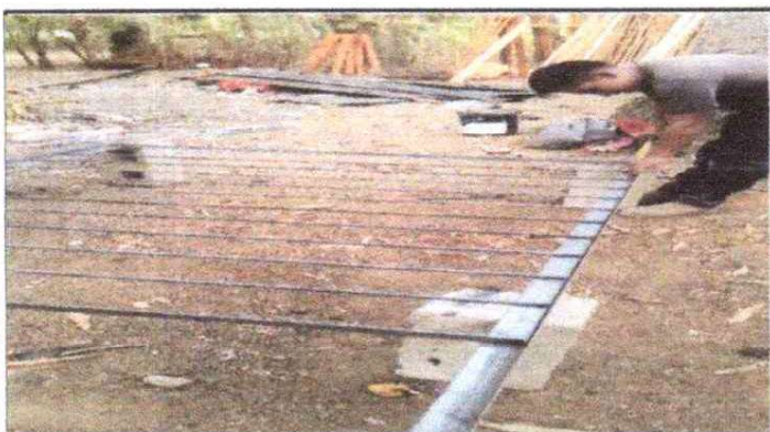
FOTO 3: SUSTITUCIÓN DE VENTANAS DE MADERA POR BALCONES DE METAL.
