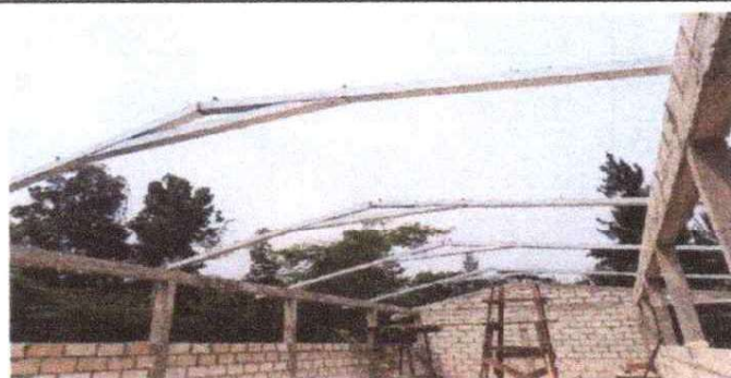
FOTO 2: SUSTITUCIÓN DE ESTRUCTURA DE MADERA POR METAL.
