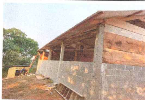
FOTO 2: Parte de atrás de las dos aulas nuevas
