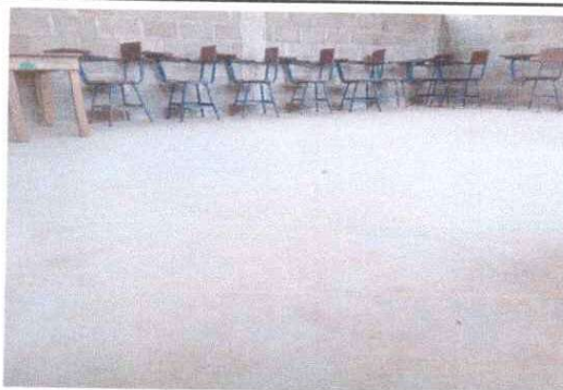
FOTO 4: Se puede ver el piso dentro de las dos aulas e incluso ya está en uso por los niños
