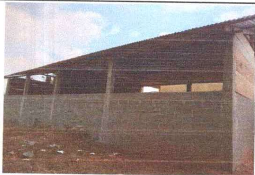
FOTO 3: Vista de la parte de atrás de las dos aulas
