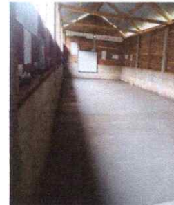
FOTO 2: REPARACION DE PISO TORTA
