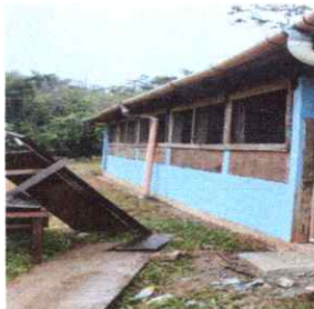
FOTO 5: INSTALACION DE CANALES DE LLUVIA
