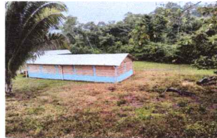
FOTO 4: PINTURA EN MUROS INTERIOR Y EXTERIOR
