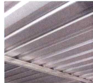
FOTO 5: INSTALACION DE ESTRUCTURA DE METAL PARA TECHO
