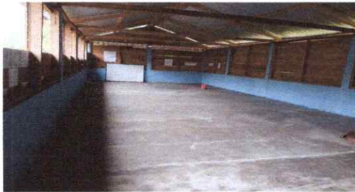
FOTO 3: PINTURA EN MUROS INTERIOR Y EXTERIOR
