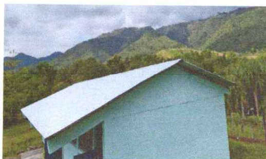
Foto2: SUSTITUCION DE LÁMINAS TROQUELADA ALUZINC CALIBRE 26
