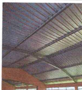
Foto 4: SUSTITUCIÓN DE ESTRUCTURA DE SOPORTE DE METAL, POR METAL ( INSTALACIÓN)
