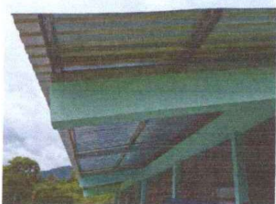
Foto1: SUSTITUCION DE LÁMINAS TROQUELADA ALUZINC CALIBRE 26
