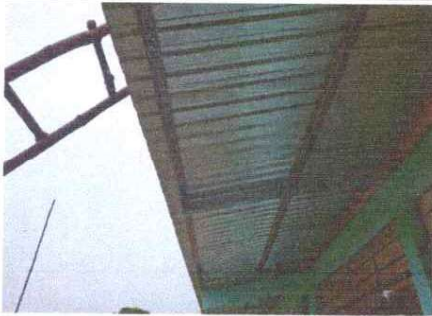
Foto 1: SUSTITUCION DE LÁMINAS TROQUELADA ALUZINC CALIBRE 26
