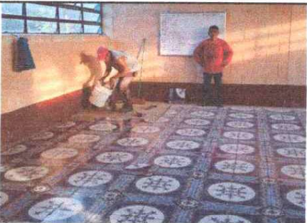
Foto 5: REPARACION DE PISO DE TORTA DE CONCRETO
