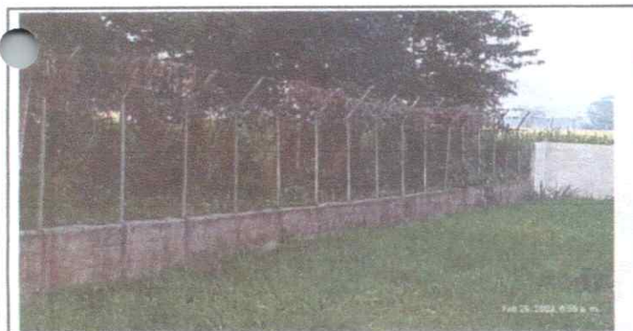
5 SUSTITUCION DE MALLA.
