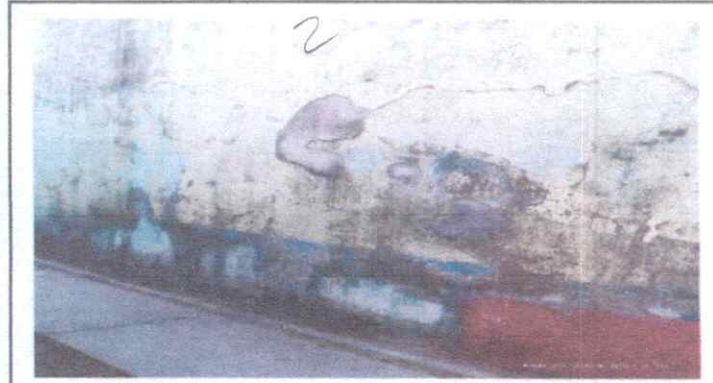
2 REPELLO Y CERNIDO DE PAREDES. PINTURA EXTERIOR E INTERIOR DE LAS AULAS
