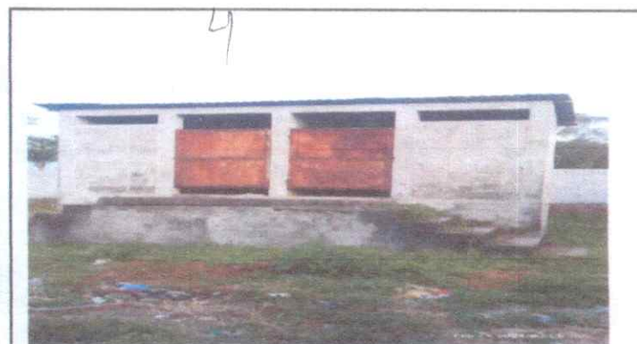
4 REPELLO Y CERNIDO DE MURO EXTERIOR E INTERIOR DE LA LETRINA. PINTURA/ SUSTITUCION DE PUERTAS
