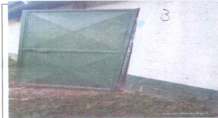
3 SUSTITUCION DE PUERTA
