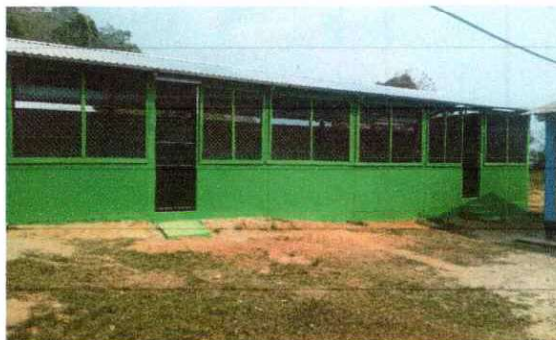
Foto 2: Sustitución de Estructura Metálica.
