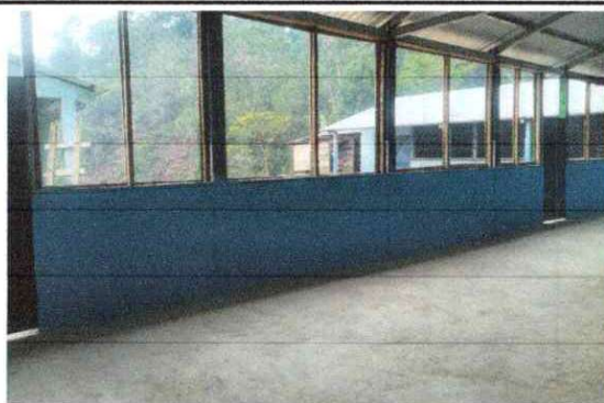
Foto 4: Sustitución de piso.
