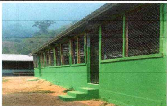
Foto 3: Mejoramiento de muro de aula.
