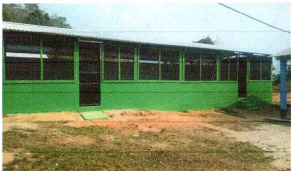
Foto 1: Sustitución de Láminas.
