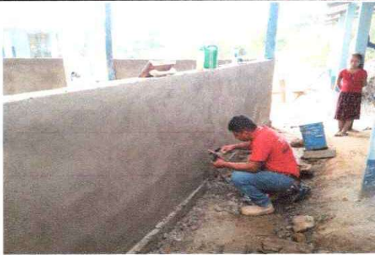
Foto 3: Mejoramiento de muro de aula
