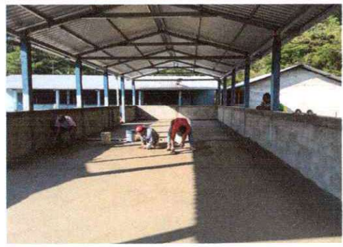
Foto 4: Sustitución de piso
