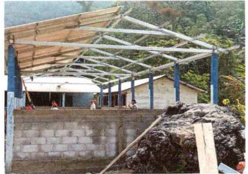
Foto 2: Sustitucion de Estructura Metalica
