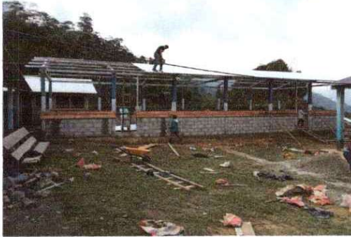
Foto 1: Sustitucion de Laminas
