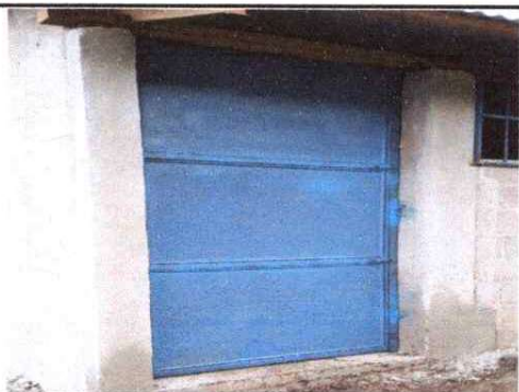
Foto 5: INSTALACIÓN DE PUERTA DE METAL.
