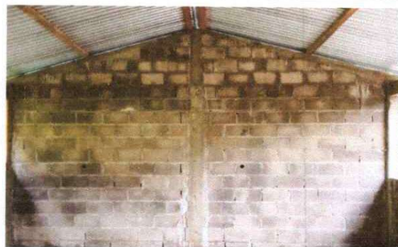
FOTO 2: SUSTITUCION DE ESTRUCTURA DE MADERA.
