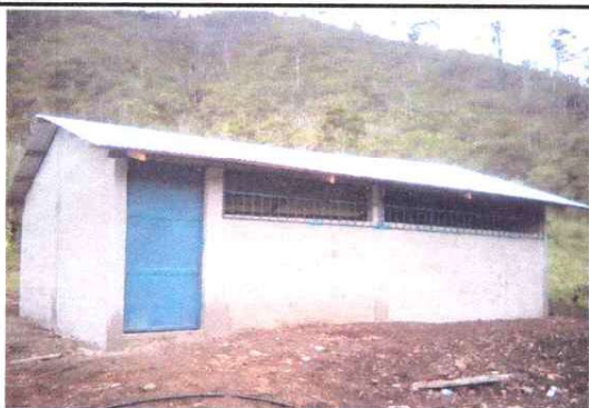
FOTO 3. SUSTITUCION DE LAMINA TROQUELADA.
