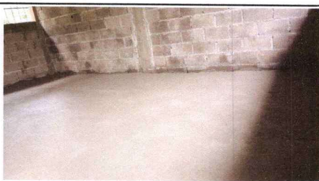
FOTO 4. DE PISO DE CONCRETO.
