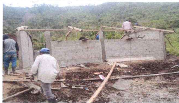
FOTO 2: SUSTITUCION DE ESTRUCTURA DE MADERA.
