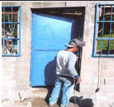
Foto 5: INSTALACIÓN DE PUERTA DE METAL.
