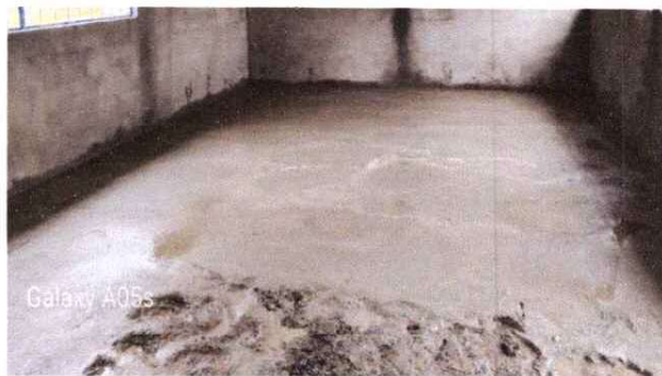
FOTO 4: SUSTITUCIÓN DE PISO DE CONCRETO.
