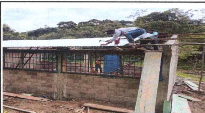
FOTO. SUSTITUCION DE LAMINA TROQUELADA.
