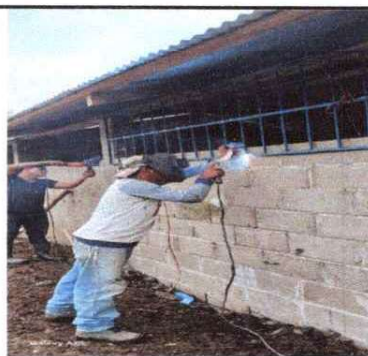
Foto 6: INSTALACIÓN DE BALCONES DE METAL.
