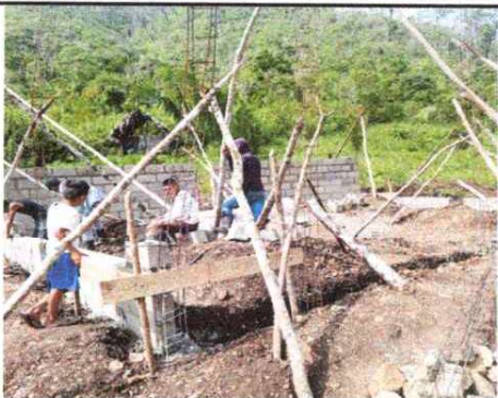
FOTO. LEVANTAMIENTO DE COLUMNA DE CONCRETO.
