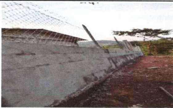
Foto 5: APLICACIÓN DE REPELLO DE MURO DE CONTENCIÓN.
