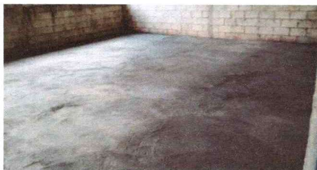
FOTO 3: APLICACIÓN DE PISO DE CONCRETO.
