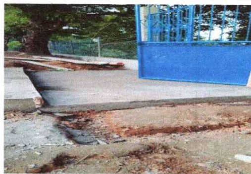
FOTO 2: SUSTITUCIÓN DE TORTA DE CONCRETO EN LA ENTRADA PRINCIPAL.
