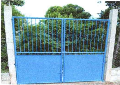
Foto1: Sustrucción de puerta de madera por metal
