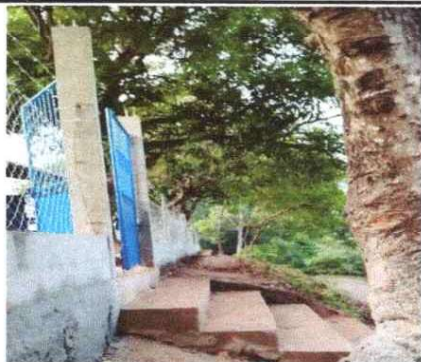
FOTO 1: SUSTITUCIÓN DE BANQUETA DE LA ENTRADA PRINCIPAL.
