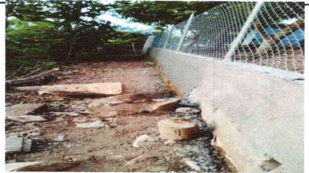
Foto 4: APLICACIÓN DE REPELLO DE MURO DE CONTENCIÓN.
