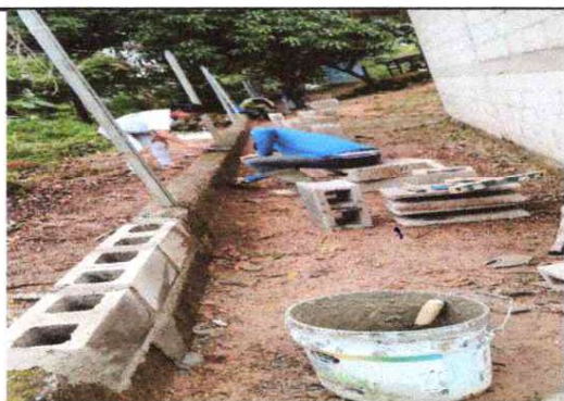
FOTO 3. REPARACIÓN DE MURO PERIMETRAL DE BLOCK CON TUBO HG Y MALLA GALVANIZADA SOLERAS INTERMEDIAS Y COLUMNAS.
