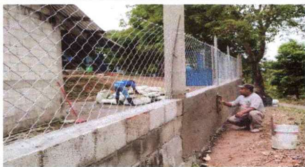
Foto 5: APLICACIÓN DE REPELLO DE MURO DE COLUMNAS.
