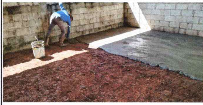
Foto 6: APLICACIÓN PISO DE CONCRETO.
