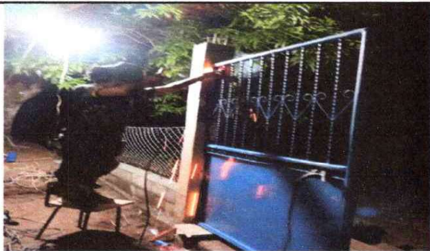
FOTO 1; SUSTITUCIÓN Y FABRICACIÓN DE PORTON DE METAL,
