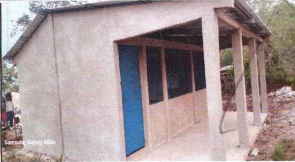
Foto 7: Finalización de instalación de balcones y puertas.
