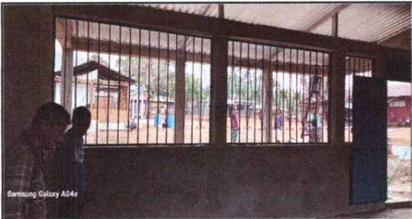
Foto 5: Instalación de balcones y puertas.
