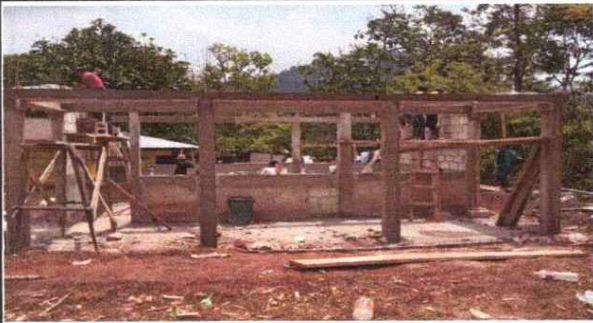
Foto 1: Levantamiento y mejoramiento de muro.
