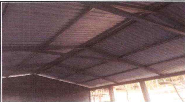
Foto 3: Instalación de estructuras metálicas.
