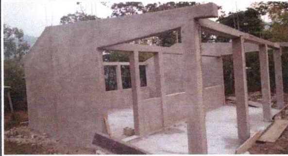
Foto 2: Terminación de mejoramiento de muro.
