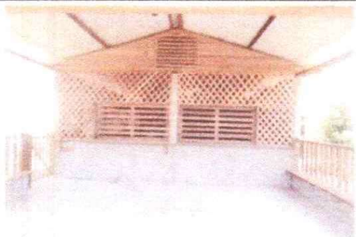
FOTO 5: Se observa una de las áreas de la cocina con su piso y paredes completamente terminado
