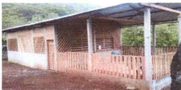
FOTO 6: La cocina tiene dos ambientes, área de cocina y área de recepción de alimentos.
