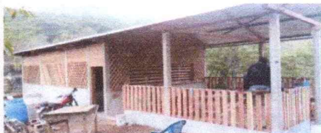
FOTO 4: Se observa la cocina en su recta final con sus paredes, techo y piso completamente terminados
