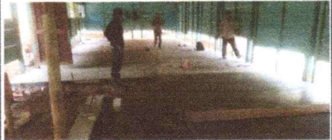
FOTO 2: Fundición y alisado de piso de las dos aulas
