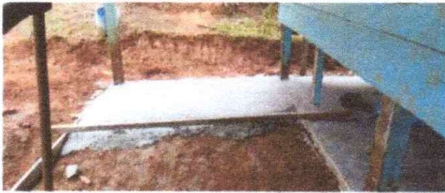
FOTO 3: Fundición de piso del corredor de las dos aulas
