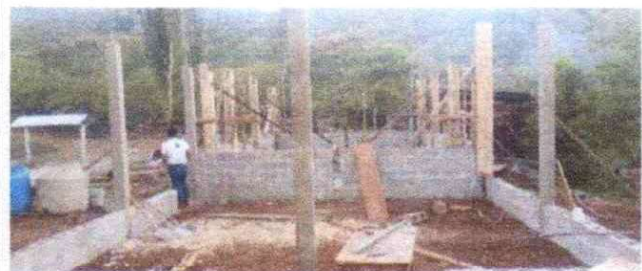
FOTO 6: Fundición de columnas de la cocina
