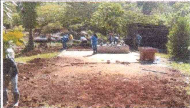
FOTO 4: Inicio de trabajo en el trazado y sanqueo de para la construcción de la cocina
