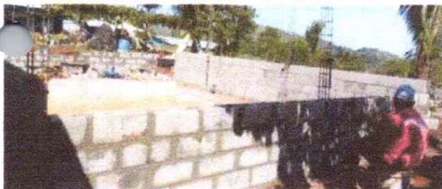
FOTO 5: Proceso de levantamiento de muro de paredes de cocina
