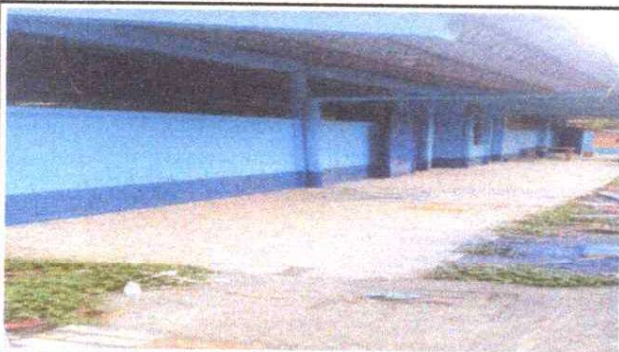
FOTO 3: PINTURA EN MUROS INTERIORES Y EXTERIORES.
