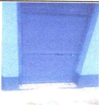
FOTO 1: SUSTITUCIÓN DE PUERTAS.
