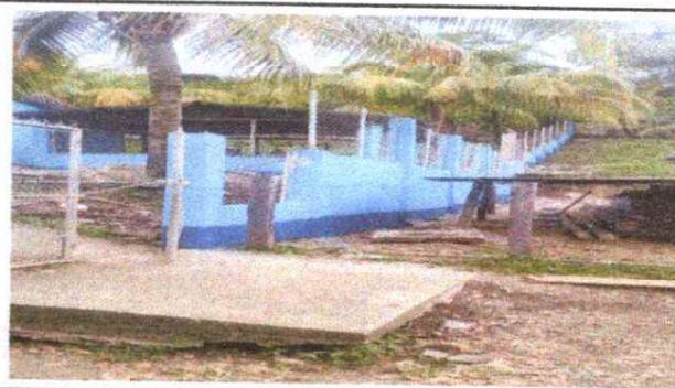
FOTO 4: SUSTITUCIÓN DE MURO PERIMETRAL
