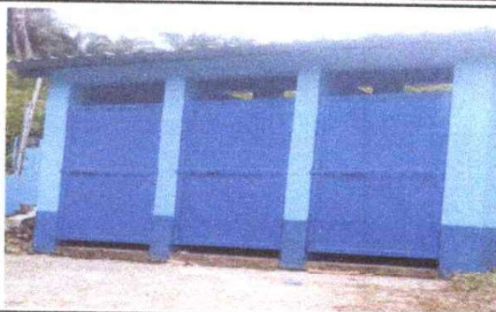
FOTO 2: SUSTITUCIÓN DE PUERTAS.
