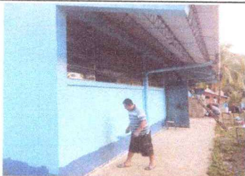
FOTO 3: PINTURA EN MUROS INTERIORES Y EXTERIORES.
