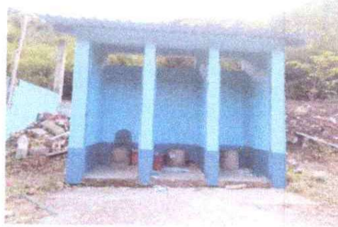
FOTO 2: SUSTITUCIÓN DE PUERTAS DE BAÑO.
