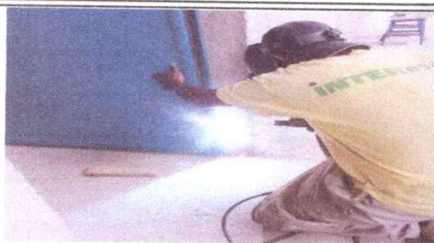
FOTO 1: SUSTITUCIÓN DE PUERTAS.
