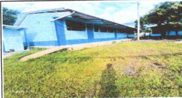
FOTO 4: PINTURA EN MUROS EXTERIORES E INTERIORES.
