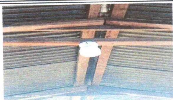
FOTO 7: REPARACIÓN DE SISTEMA ELÉCTRICO.
