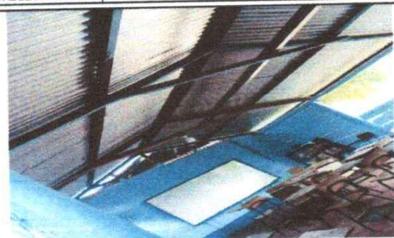
FOTO 1: SUSTITUCIÓN DE LÁMINA
