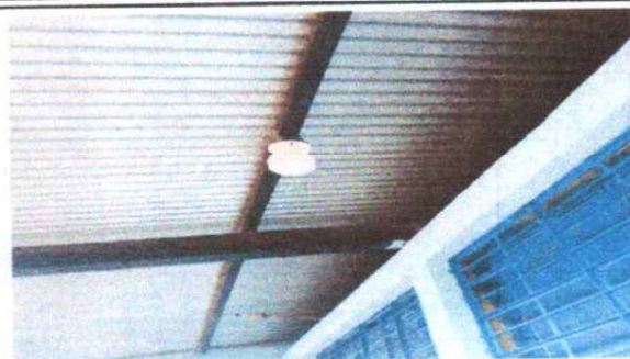
FOTO 8: REPARACIÓN DE SISTEMA ELÉCTRICO.
