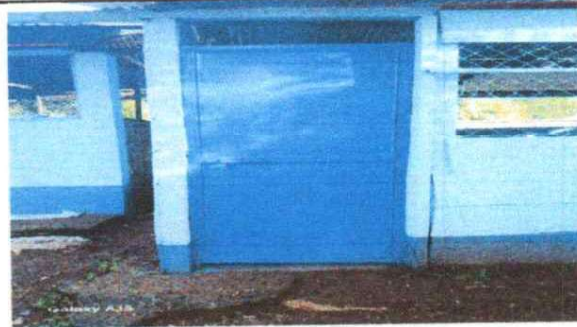
FOTO 2: MANTENIMIENTO DE PUERTAS PRINCIPALES.
