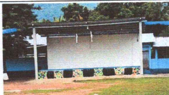
FOTO 10: REPELLO DE MURO.
