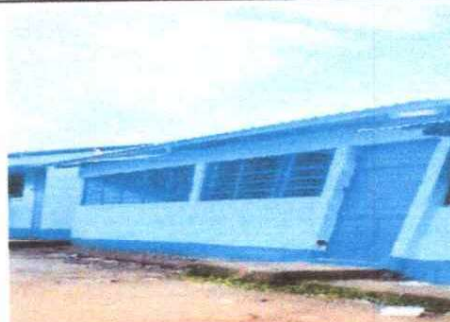
Foto 12: INSTALACION DE LAMINA TROQUELADA,
