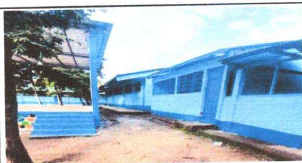
FOTO 3: PINTURA EN MUROS EXTERIORES E INTERNOS
