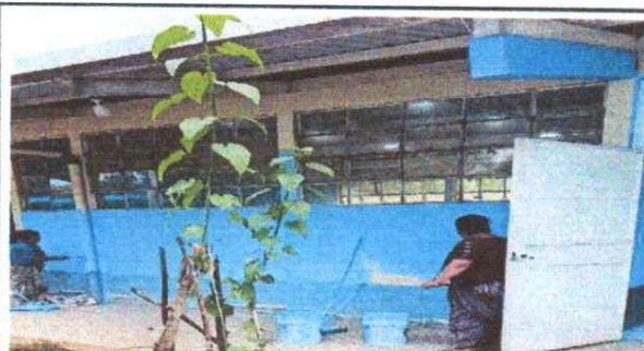
FOTO 4: PINTURA EN MUROS EXTERIORES E INTERIORES.
