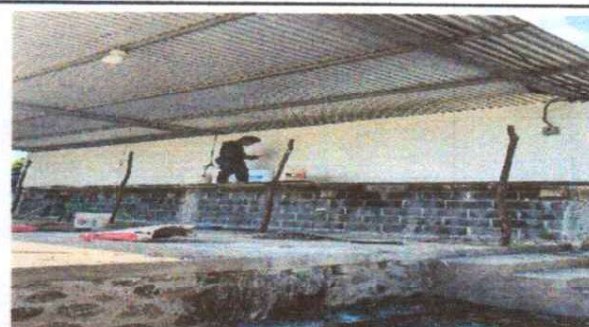
FOTO 10: REPELLO DE MURO.
