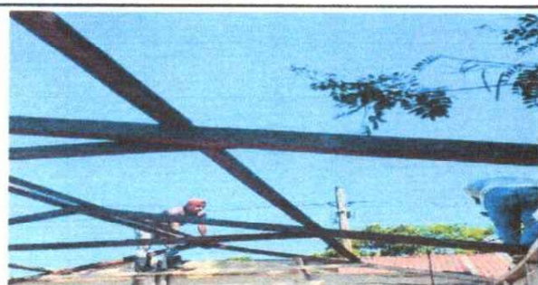
Foto 11: SUSTITUCIÓN DE ESTRUCTURA METALICA.
