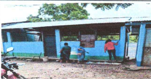
FOTO 3: PINTURA EN MUROS EXTERIOS E INTERIORES.
