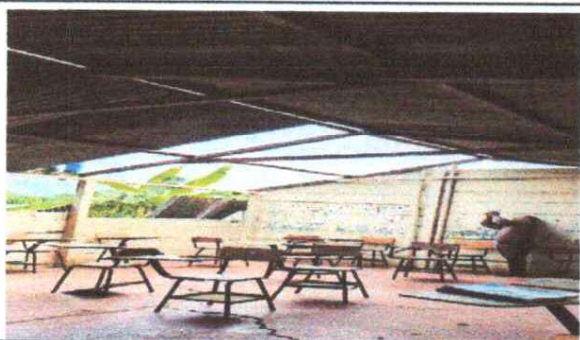
FOTO 1: SUSTITUCIÓN DE LÁMINA.
