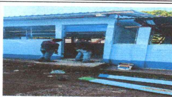
FOTO 2: MANTENIMIENTO DE PUERTAS PRINCIPALES.
