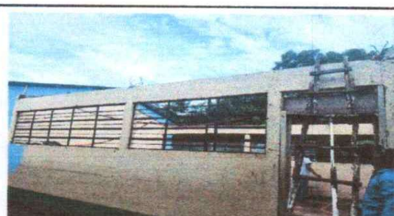
Foto 12: INSTAALCION DE LAMINA TROQUELADA.
