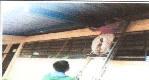
FOTO 8: REPARACIÓN DE SISTEMA ELECTRICO.
