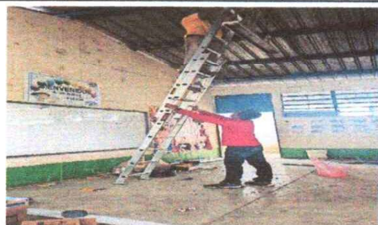
FOTO 9: REPARACIÓN DE SISTEMA ELECTRICO.
