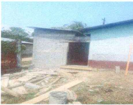
Foto 3: cambia de pila a una pileta y su estructura
