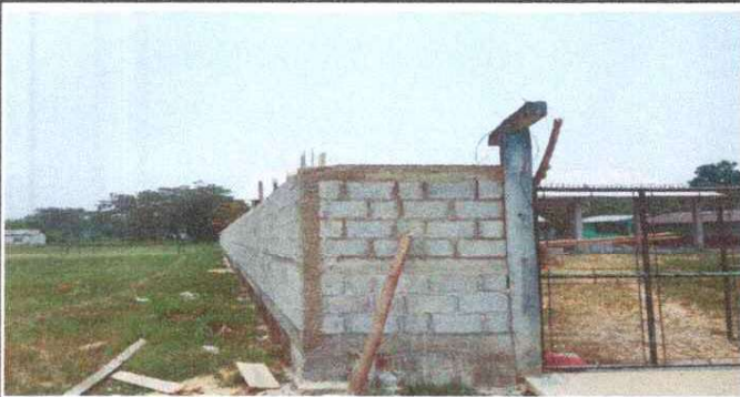
Foto 1: Cambia de malla a pared de block
