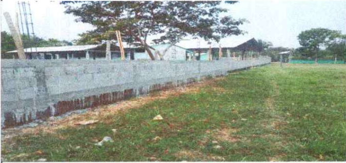
Foto 1: cambio de malla de pared de block
