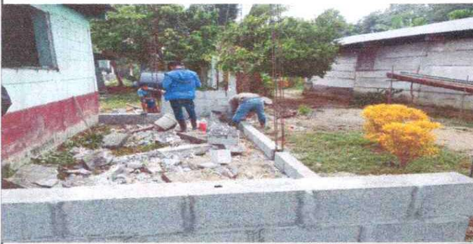
Foto 3: Cambio de pila a una pileta y su estructura
