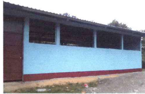
FOTO 4: SUSTITUCION PUERTA DE METAL
