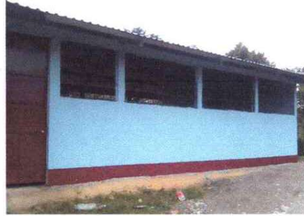
FOTO 2: ESTRUCTURA DE TECHO
