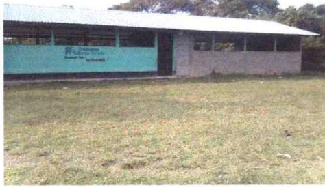
FOTO 1: CUBIERTA DE LÁMINA CENTRO EDUCATIVO
