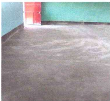
FOTO 5: SUSTITUCIÓN DE PISO DE CONCRETO
